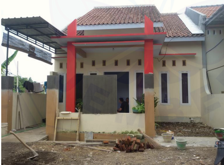
Gambar 4.17 Foto pembangunan rumah di lokasi Jalan Kasuari Gang IV kedawung Cabang Patrang
