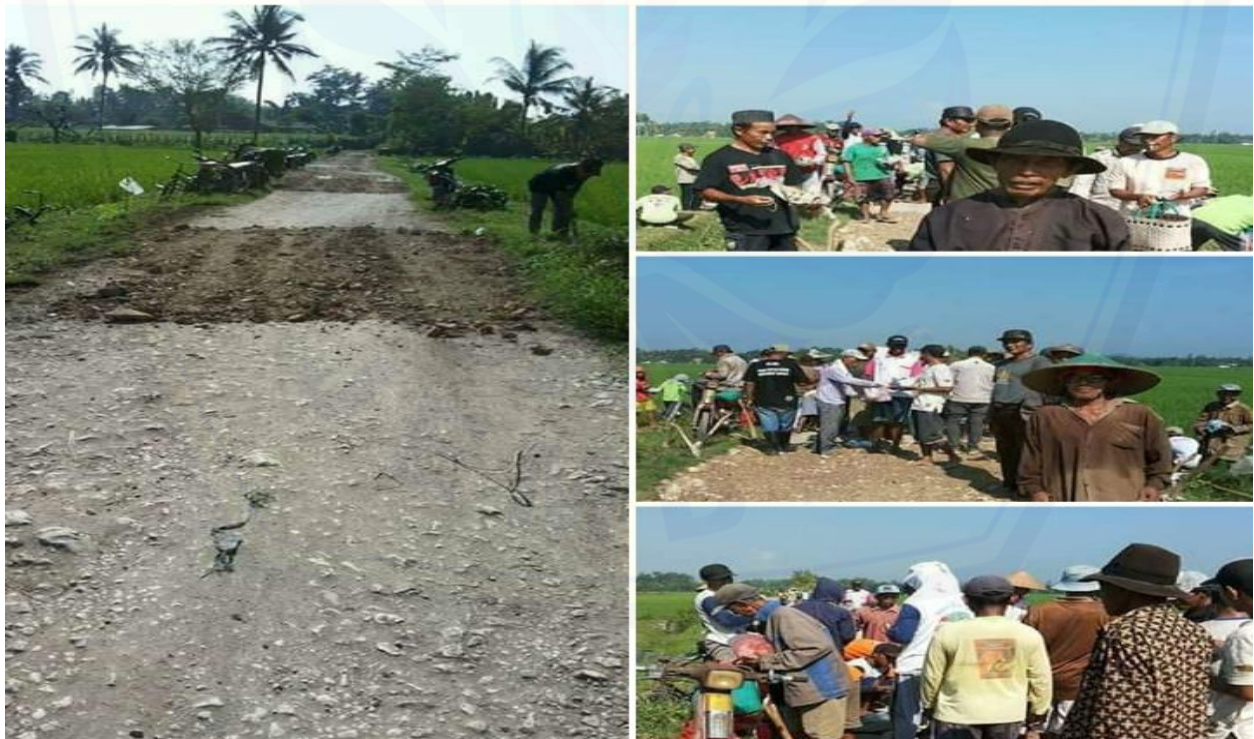
Gambar 15. Partisipasi Masyarakat Membantu Pembangunan Jalan Desa Jambearum
