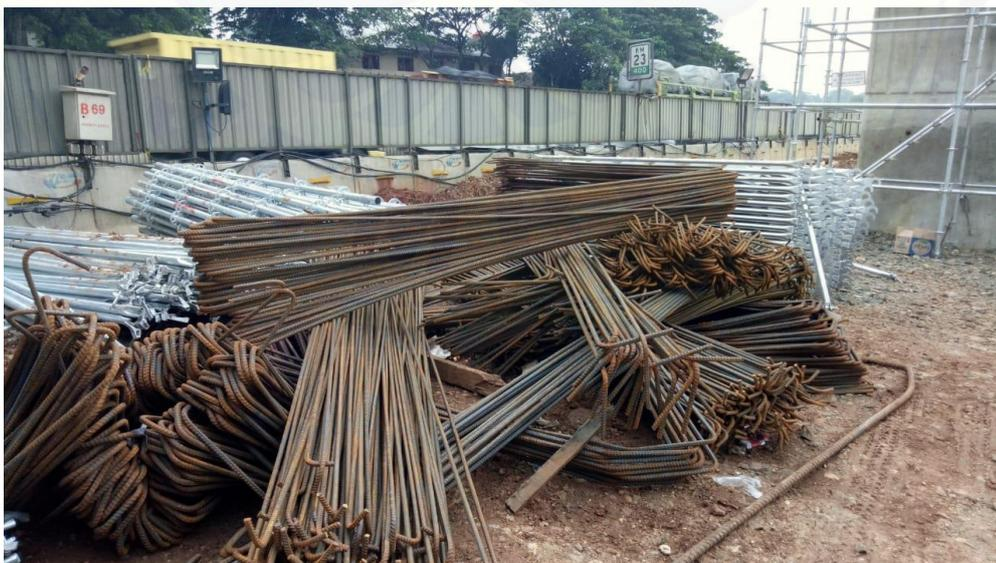
**Gambar 6.2** Besi tulangan pekerjaan *pier head*
