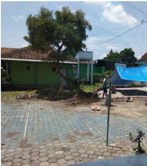
Kondisi kantor Desa Badean saat pembangunan taman
