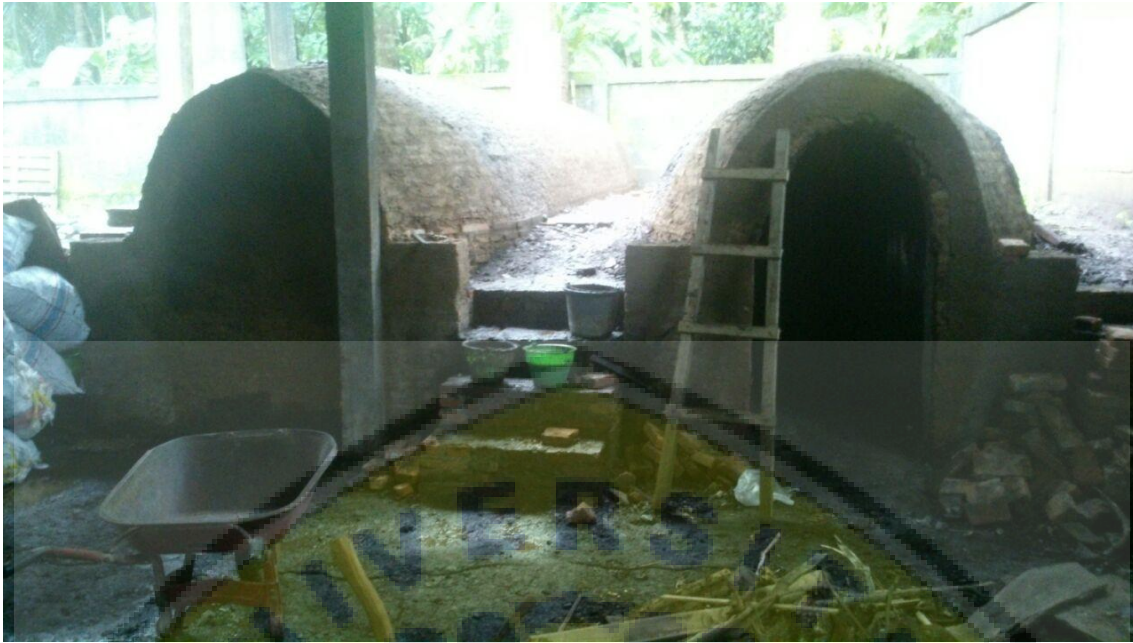
Gambar 1. Pembuatan Tungku Pemanas Bertekanan Tinggi
