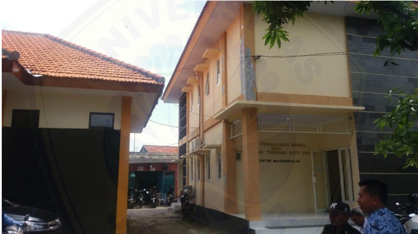
Gambar A.5 Tampak Gedung Kantor Perijinan Kabupaten Bangkalan
