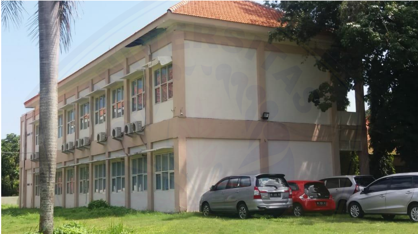
Gambar A.3 Tampak Gedung Kantor Balai Diklat Kabupaten Bangkalan
