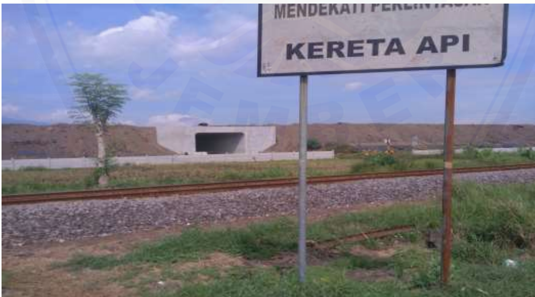
F. 2 Proses pembangunan proyek jalan tol
