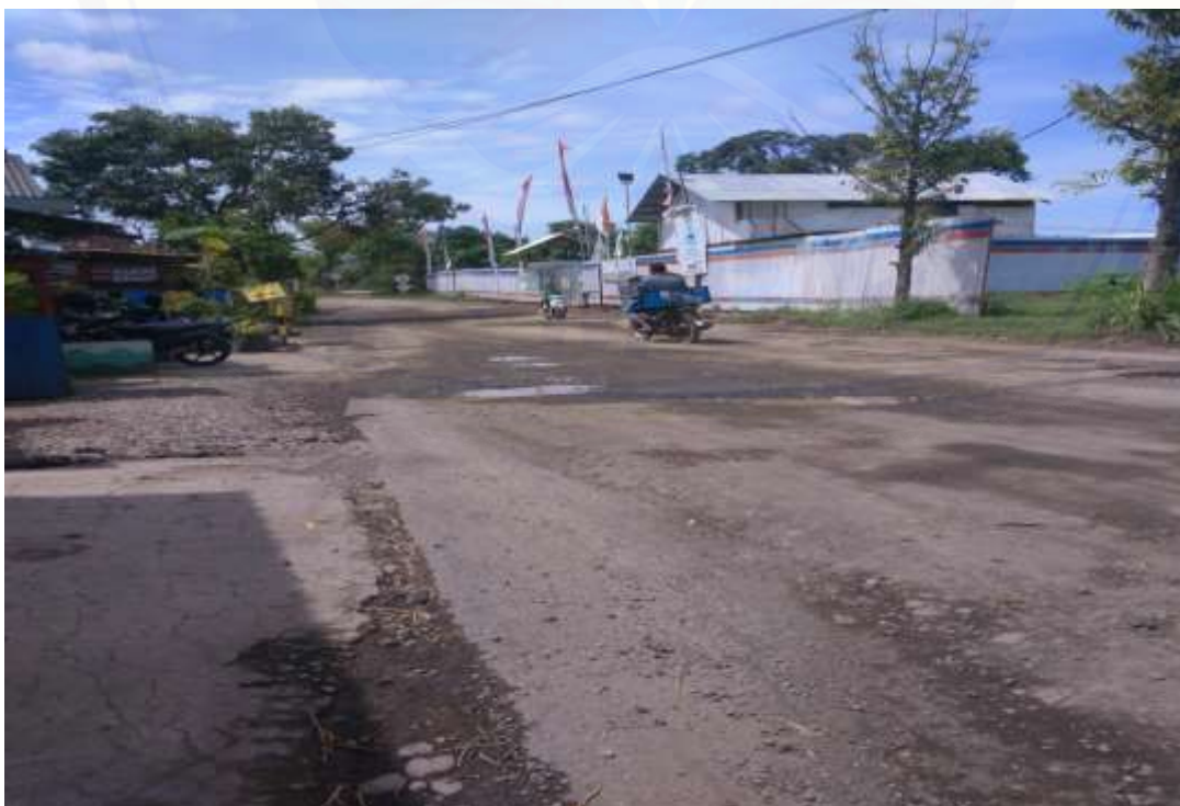
G. 4 Jalan dan lingkungan yang ikut rusak
