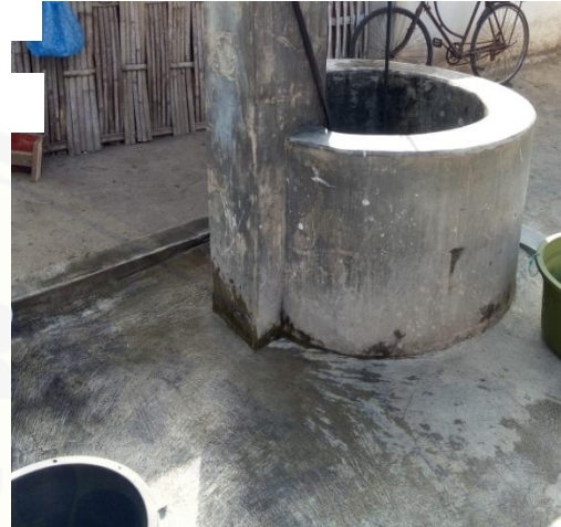
Gambar 14. Lantai Sumur yang Memenuhi Persyaratan
