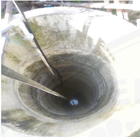
Gambar 13. Dinding Sumur yang Memenuhi Persyaratan
