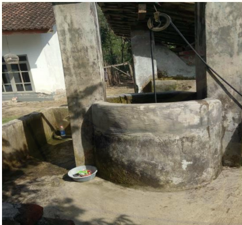
Gambar 15. Parapet yang Memenuhi Persyaratan
