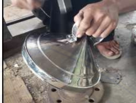
Gambar 2.4 Pemasangan Pegangan Tutup Dandang
