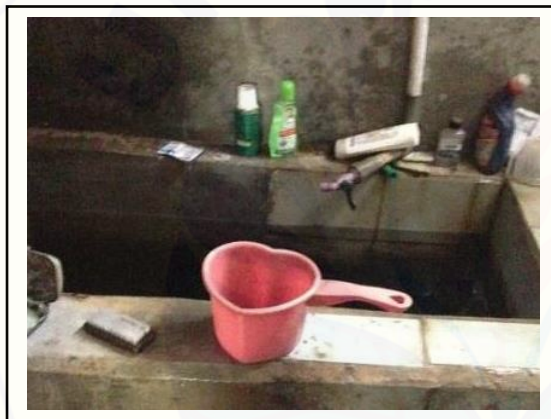
Gambar 3. Tempat Penampungan Air Kotor
