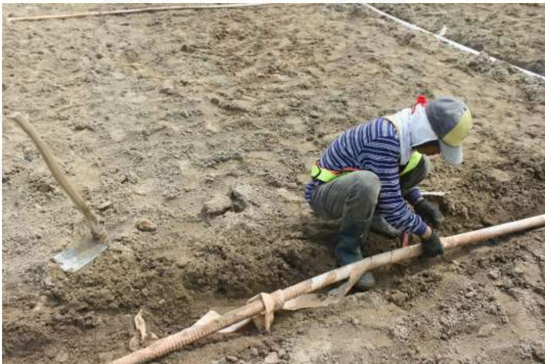
Lampiran 4 Pemasangan Pipa Perforasi
