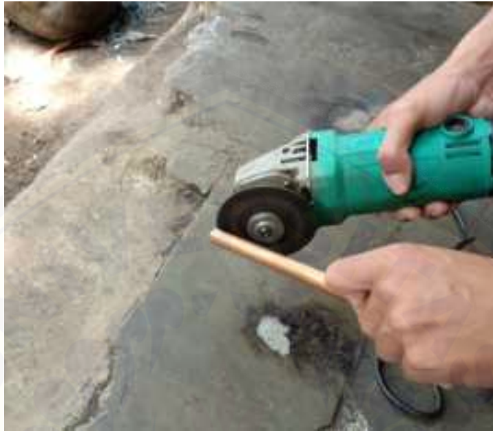
Gambar lampiran a). Memperhalus permukaan pipa air setelah dipotong
