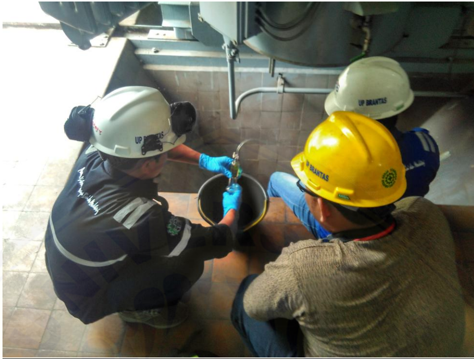
Gambar Pengambilan Minyak Transformator Untuk UJi Dissolved Gas Analysis (DGA)
