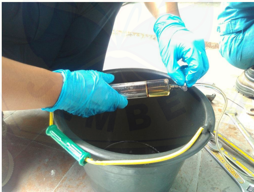
Gambar Proses Pengambilan Minyak Pada Transformator Untuk UJi Dissolved Gas Analysis (DGA)
