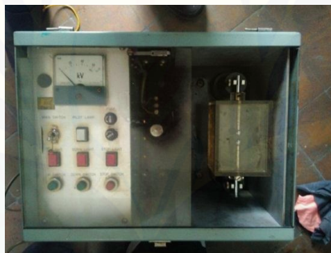
Gambar 4.15 Pengujian Tegangan Tembus pada minyak transformator 1
