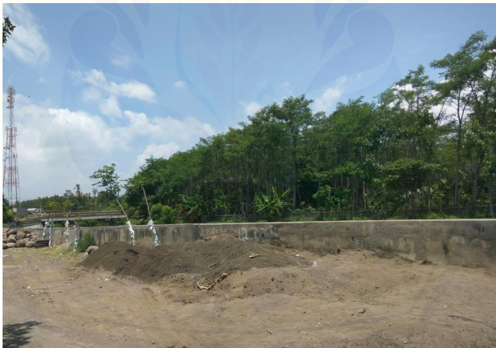
Gambar pembangunan plengsengan di Kecamatan Besuki
