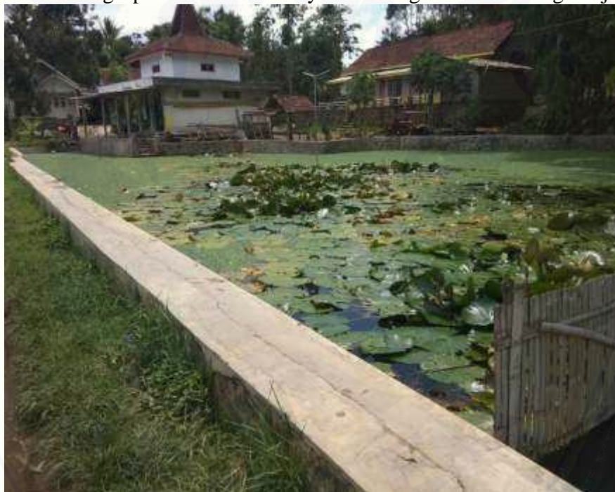
Gambar Pembangunan Embung Dusun Sumberpinang Rt 02/ Rw 30 Desa Karangharjo
