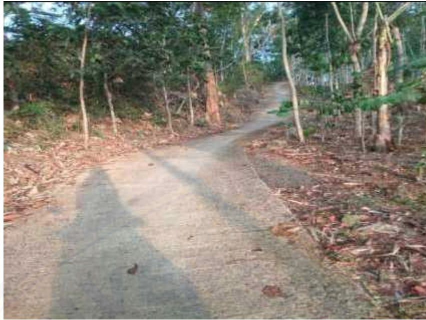
Gambar Pembangunan Jalan Rabat Beton Rt 02/ Rw 12 Dusun Gluguh Desa Karangharjo
