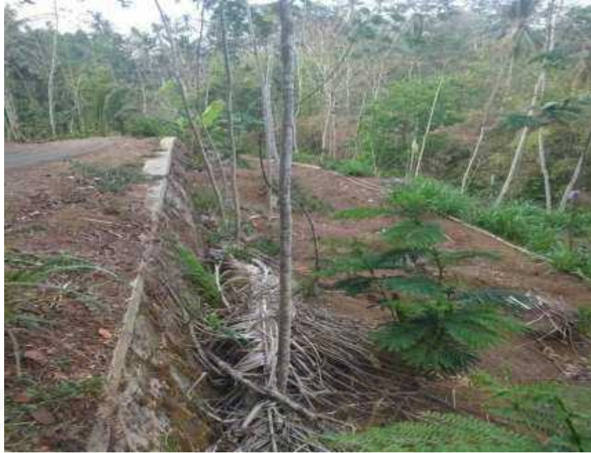
Gambar Pembangunan Tembok Penahan Tanah (TPT) Dusun Gluguh Rt 03/ Rw 12 Desa Karangharjo
