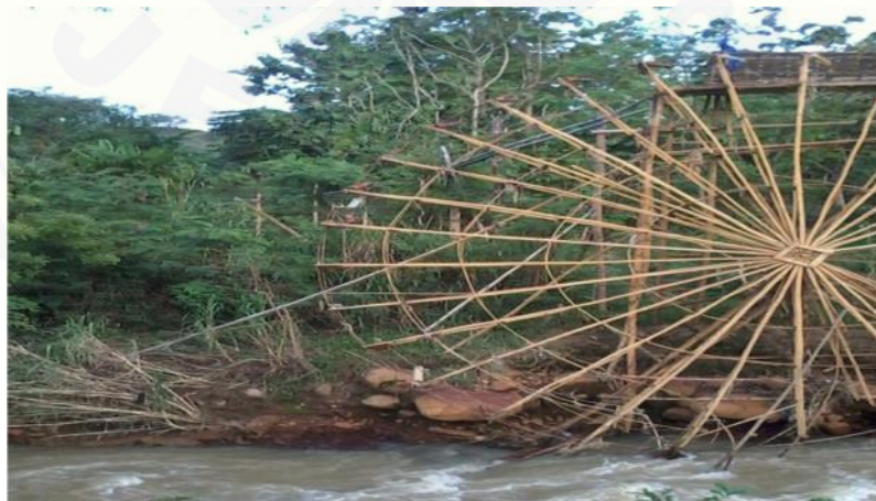
Kincir Rusak Akibat Banjir
