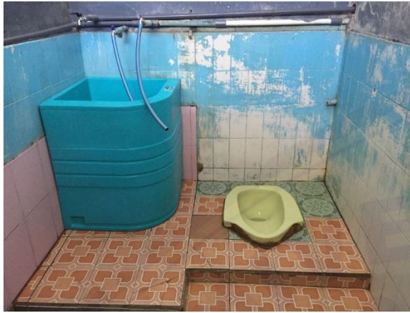
Gambar 9. Kamar mandi narapidana perempuan
