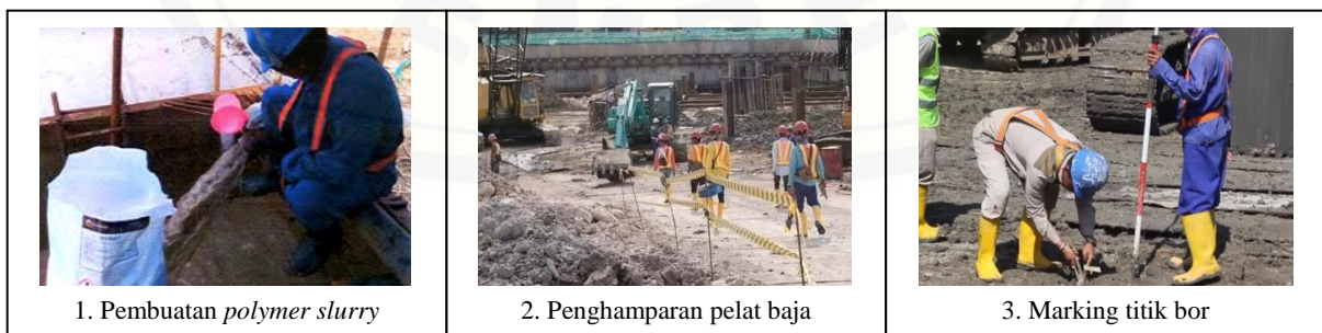
Dokumentasi pekerjaan pengeboran lubang bored pile
