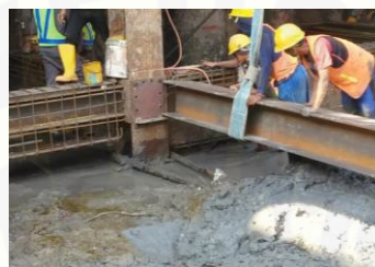
2. Pemasangan balok strutting
