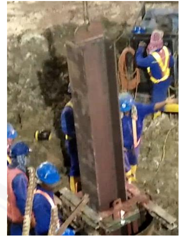
3. Pemasangan plunge column
