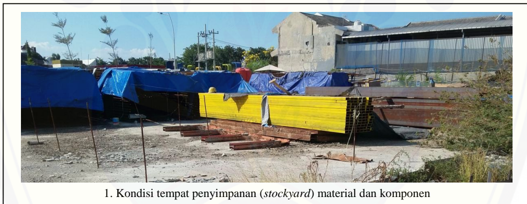
Dokumentasi pekerjaan penyimpanan material fabrikasi dan komponen jadi
