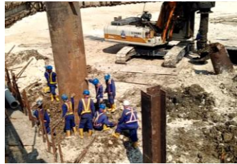
4. Pembongkaran external casing
