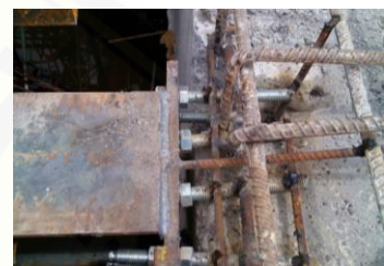
3. Balok strutting pada struktur lain
