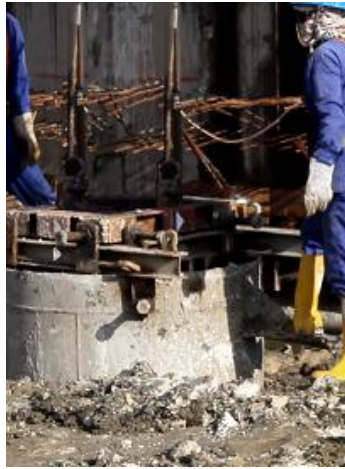
1. Pemasangan meja follower
