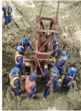
2. Pemasangan follower frame
