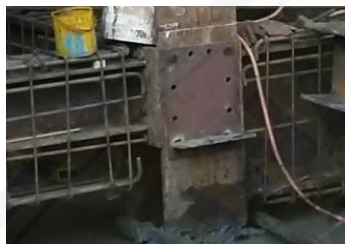
1. Pemasangan pelat sambung
