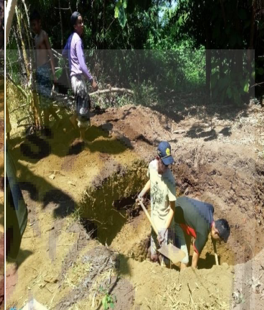
Pembangunan pondasi reaktor biogas di Desa Kareng Kidul
