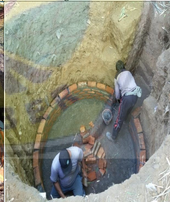
Pembangunan pondasi reaktor biogas di Desa Kareng Kidul
