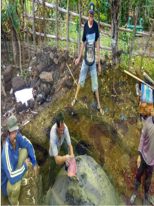
Pemasangan instalasi reaktor biogas di Desa Patalan
