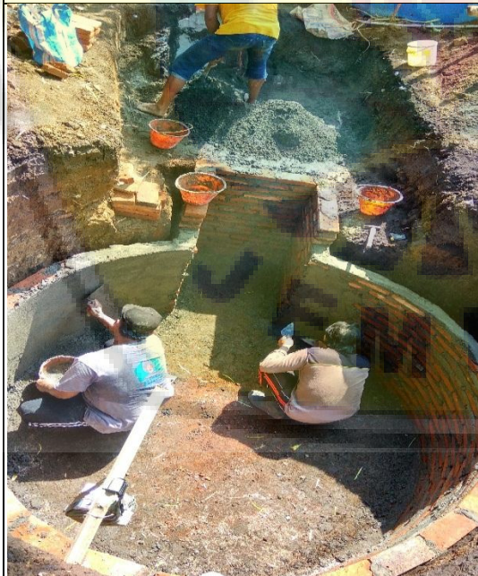
Pembangunan pondasi reaktor biogas di Desa Patalan
