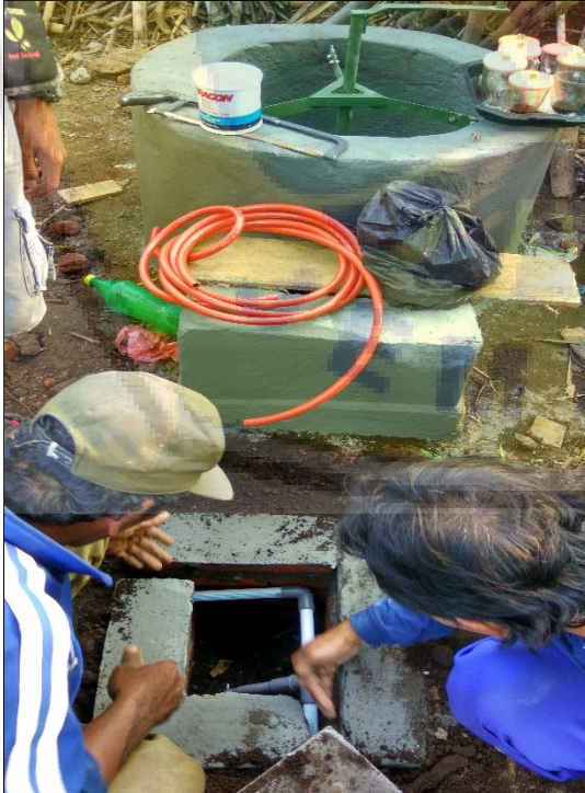
Pemasangan instalasi reaktor biogas di Desa Patalan
