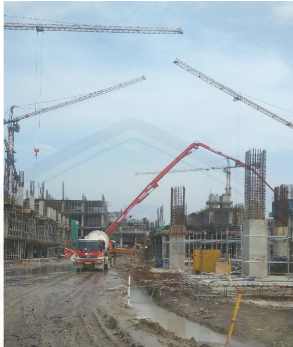
Gambar 2.2 Pekerjaan Pengecoran Kolom Menggunakan Concrete Pump (Sumber : dokumentasi pribadi)
