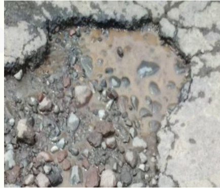
Gambar 2.16 Lubang (Sumber: Dokumentasi Pribadi)
