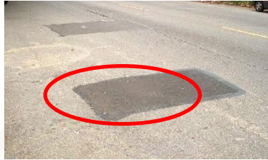
Gambar 2.21 Penurunan pada bekas penanaman utilitas (Sumber: https://kerusakanjalann.blogspot.com )
