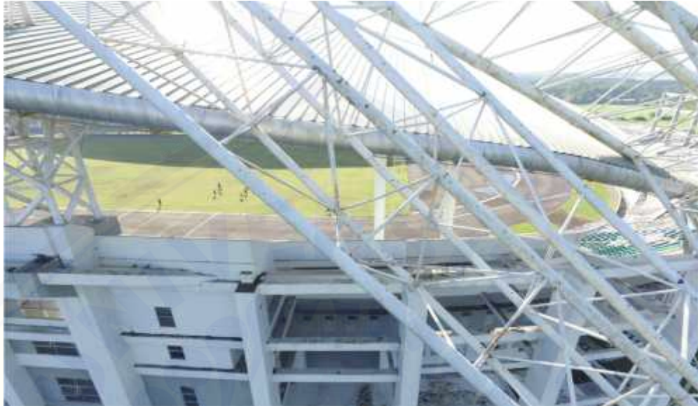
Lampiran 3. Melihat Kondisi Atap Menggunakan Kamera Drone
