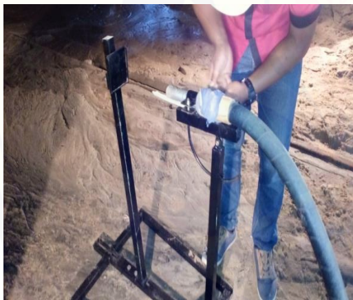
Pemasangan nozzle ke alat bantu
