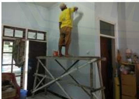
Gambar 13. Renovasi Rumah TKW
