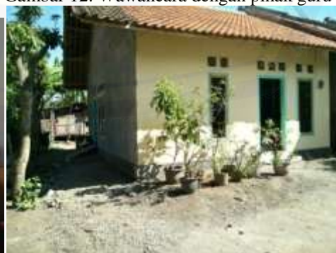
Gambar 14. Renovasi Rumah TKW 2
