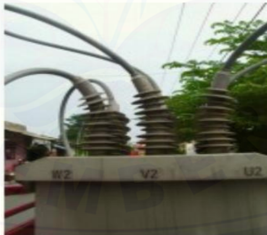
Gambar.2.8 Contoh penempatan bushing recloser sisi beban
