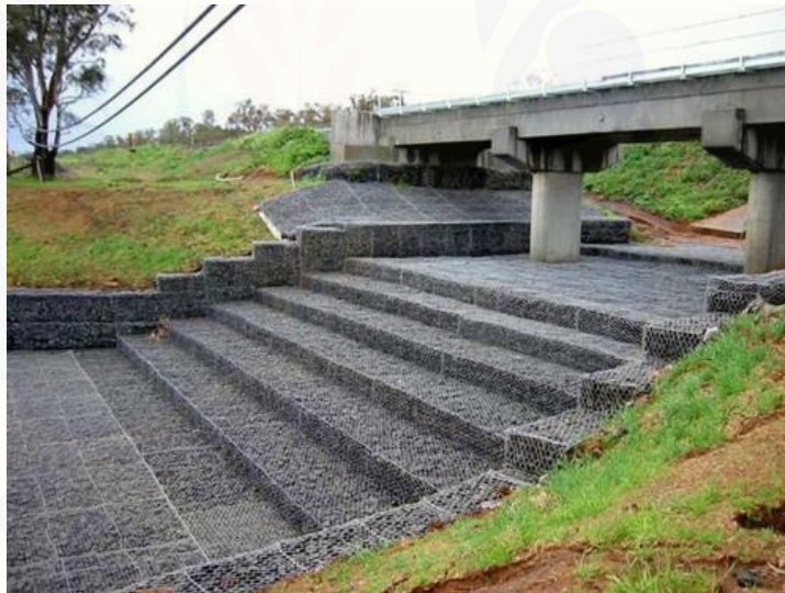
Gambar 2.9 Bendung Bronjong Semi-permanen
