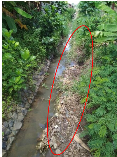
Gambar 2.5 Sedimentasi pada saluran irigasi
