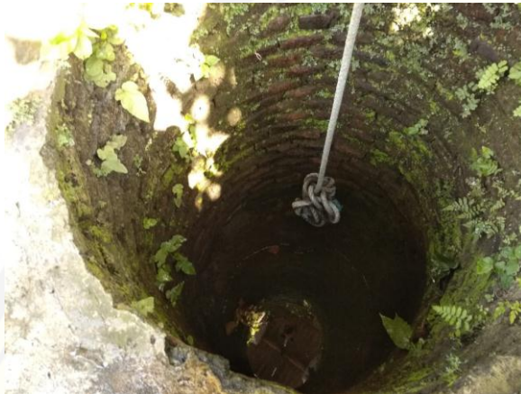
Kondisi Dinding Sumur
