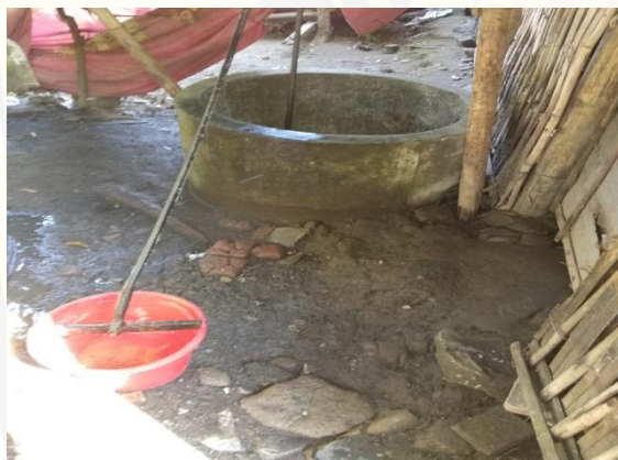
Kondisi Sumur tidak memiliki Lantai
