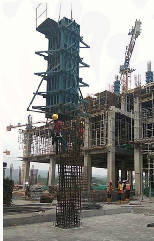
Gambar 2.5 Pemasangan bekisting balok dengan bantuan tower crane
