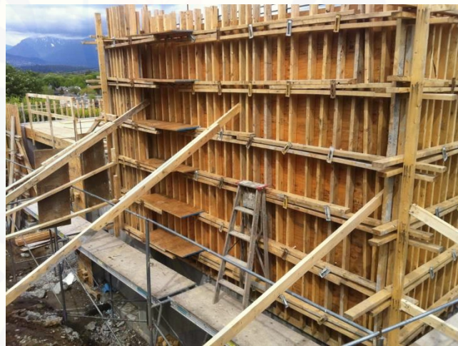
Gambar 2.1 Bekisting Kolom Konvensional
