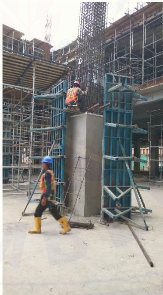
Gambar 2.8 Bekisting Kolom yang Telah Dilepas dari Cetakan
