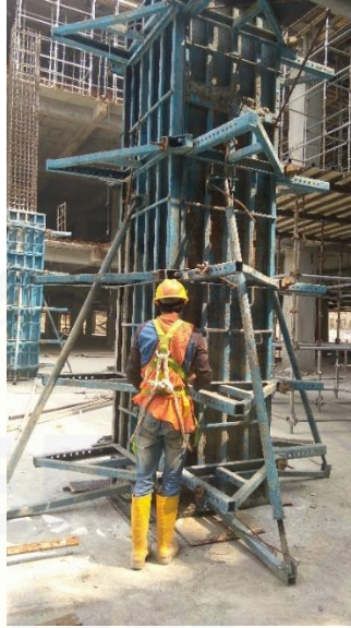
Gambar 2.7 Pengenduran Tierod dan Tie Nut
