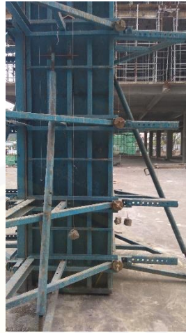
Gambar 2.6 Bekisting Kolom yang Siap Cor
