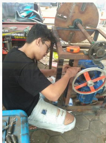
Gambar C.5 Proses Pemasangan Motor dan Reducer
