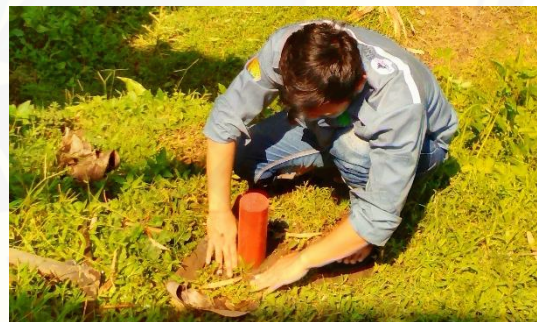
Pemasangan Patok BM
