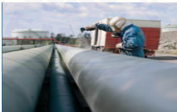
Gambar 2.1 Proses Sand blasting (Sumber : TEKNOS , 2012)
