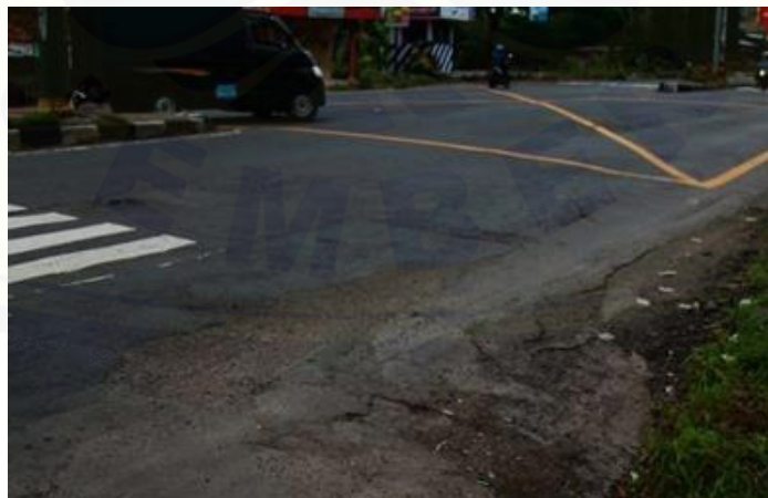
Gambar 2.6 Cacat Tepi Perkerasan (Sumber: Google Images, 2018)
