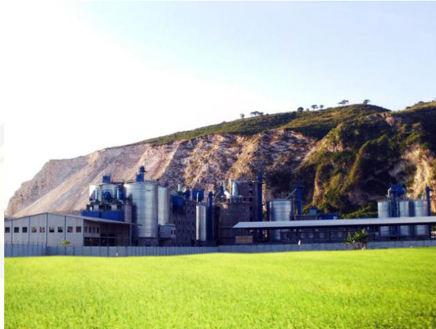
Gambar 2.1 Pabrik semen Puger (Sumber : Palugadasemenpuger, 2016)
