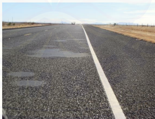
Gambar 2.20 Pengelupasan Lapisan Permukaan ( stripping ) (Sumber: Google Images)
