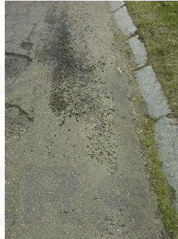
Gambar 2.19 Pelepasan Butiran ( raveling ) (Sumber: Google Images)
