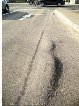
Gambar 2.17 Jembul ( upheaval ) (Sumber: Google Images)
