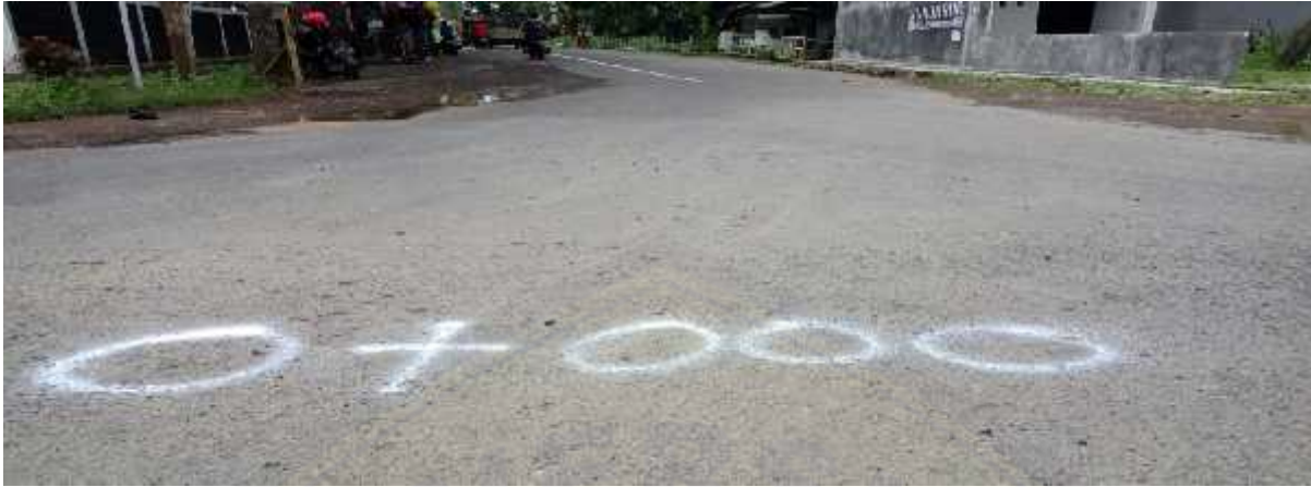
Pengukuran STA Awal pada jalan Wirowongso
