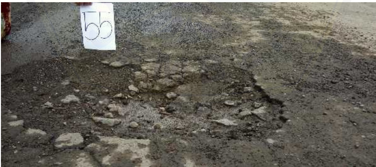
Jenis Kerusakan Lubang dengan Kedalaman <math>< 50\text{mm}</math>
