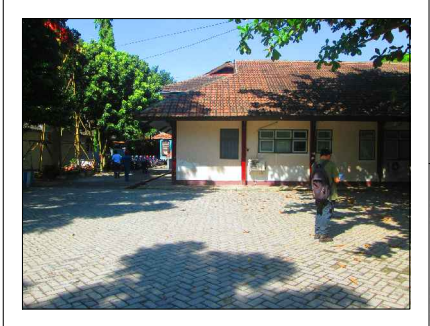
BANGUNAN YANG DI BONGKAR
