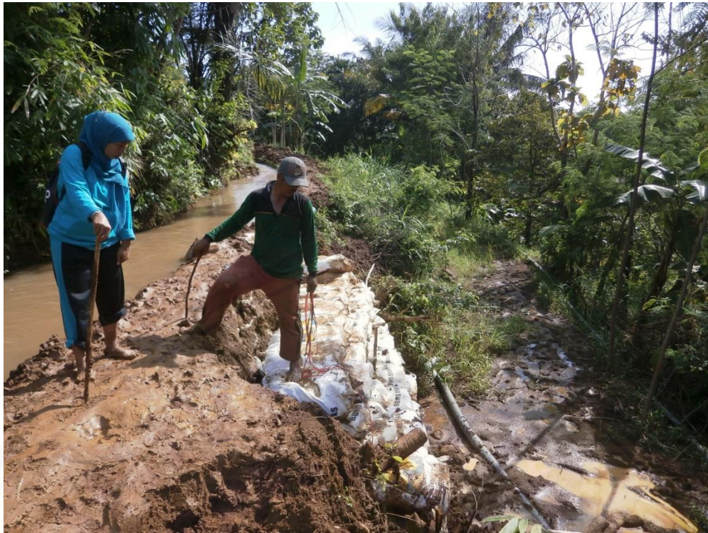
Pengawasan Pekerjaan oleh Kepala UPTD. 2016 Jaringan Irigasi Kahuripan Desa Gading Kecamatan Gading Kab. Probolinggo
