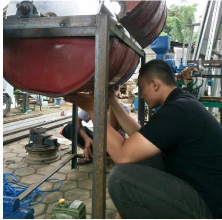
Gambar C.18 Proses Pemasangan Drum Penutup
