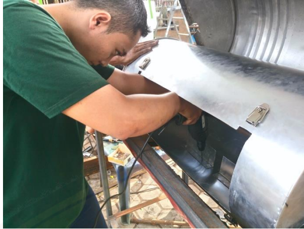
Gambar C.27 Proses Pemasangan Pengaduk didalam Tabung
