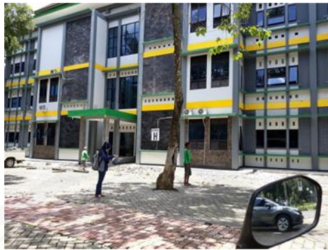
Gedung H FKIP Belum memiliki groud reservoir
