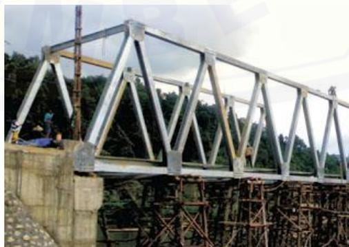
Gambar 2.6 Contoh Jembatan Rangka
