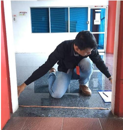
Observasi dan Pengukuran Pintu Darurat di gedung PT. Telkom Jember
