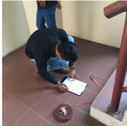
Observasi dan Pengukuran Tangga Darurat di gedung PT. Telkom Jember
