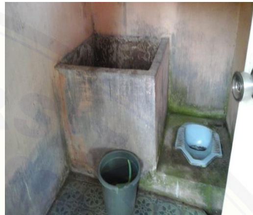
Observasi sarana sanitasi (sarana penyediaan air bersih tidak memenuhi syarat sanitasi air bersih dan pembuangan kotoran/jamban ada dengan bentuk leher angsa) rumah responden
