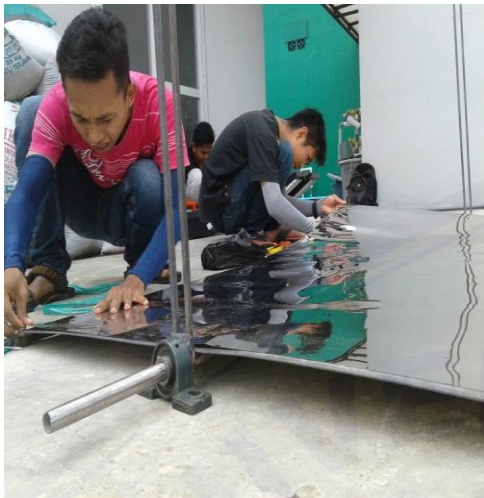
Gambar Pemasangan Kolektor
