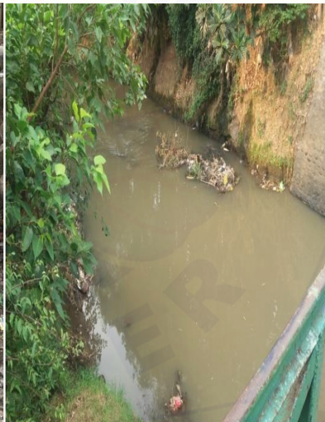
Gambar 12. Saluran Akhir Pembuangan SPAL
