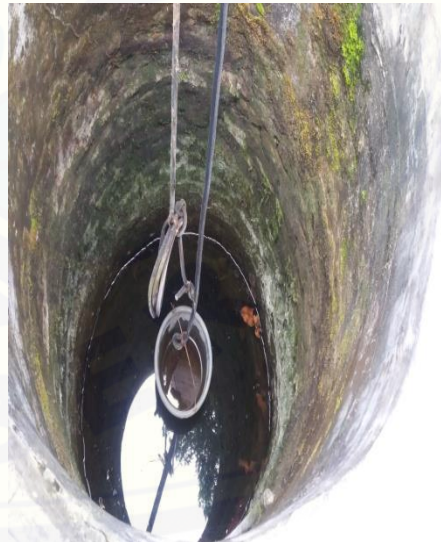
Gambar 4. Dinding Sumur Gali
