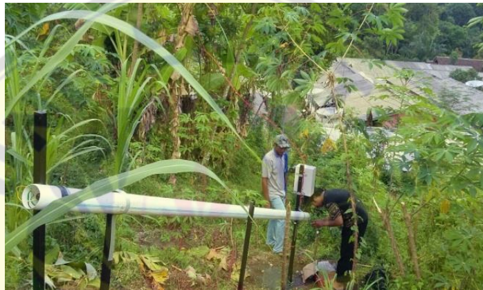
Gambar 5.2. Instalasi Sensor di Lokasi
