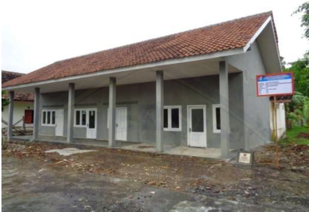
Gambar pembangunan pustu
