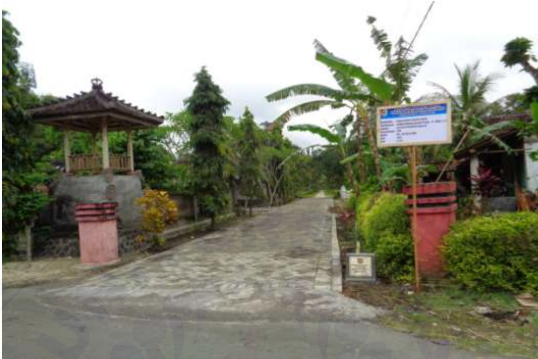
Gambar pemasangan paving halaman pure
