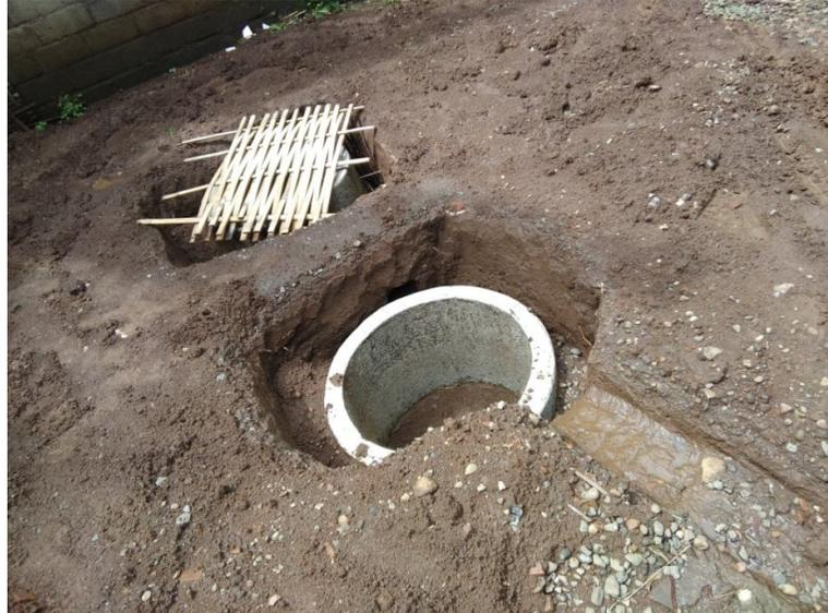
Gambar 5.4 instalasi gorong-gorong pada sumur resapan dan sumur penghancur.
