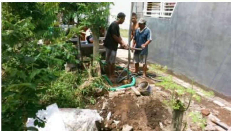
Gambar 18. Pembuatan sumur bor sebagai sumber pengairan kebun
