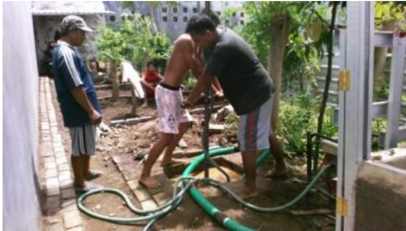
Gambar 19. Pembuatan sumur bor sebagai sumber pengairan kebun
