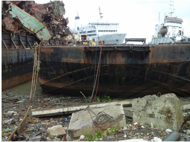
Gambar 13. Pembongkaran deck bawah bangkai kapal
